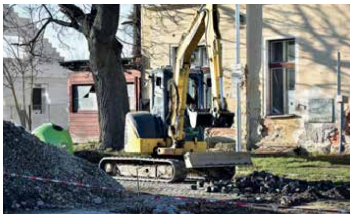
Nový povrch u nádraží se již rýsuje.
